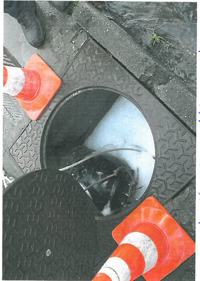
la mise en place d'un ballon gonflable pour confiner la pollution sur site.
