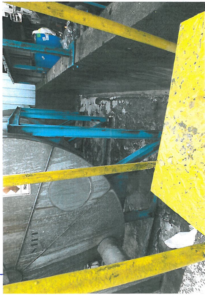
présence de Noramox dans la cuvette de rétention de la Cuve 7
